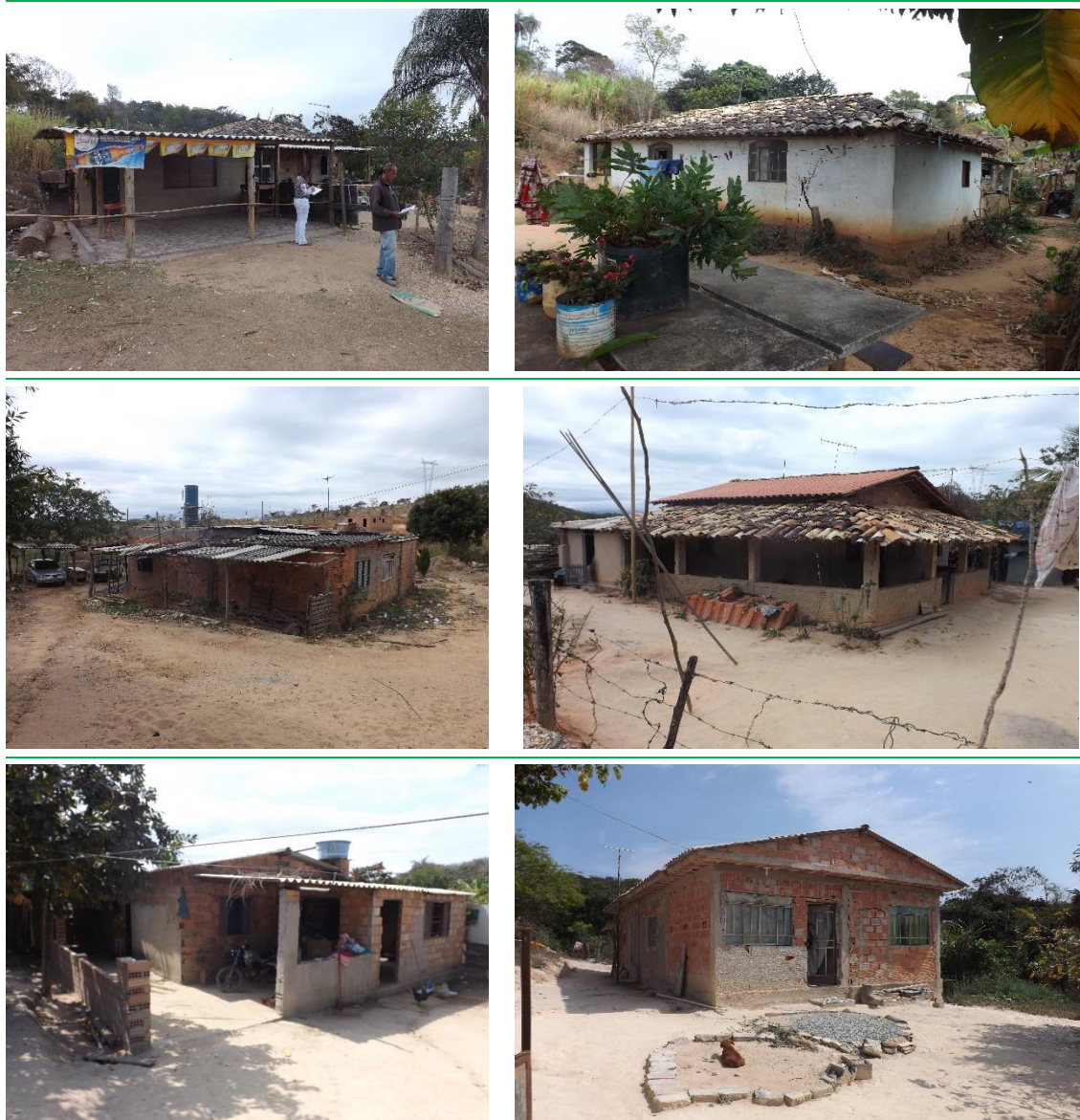
Figura 7.3 – Residências diagnosticadas em Campo de Santo Antônio / Amaro.
